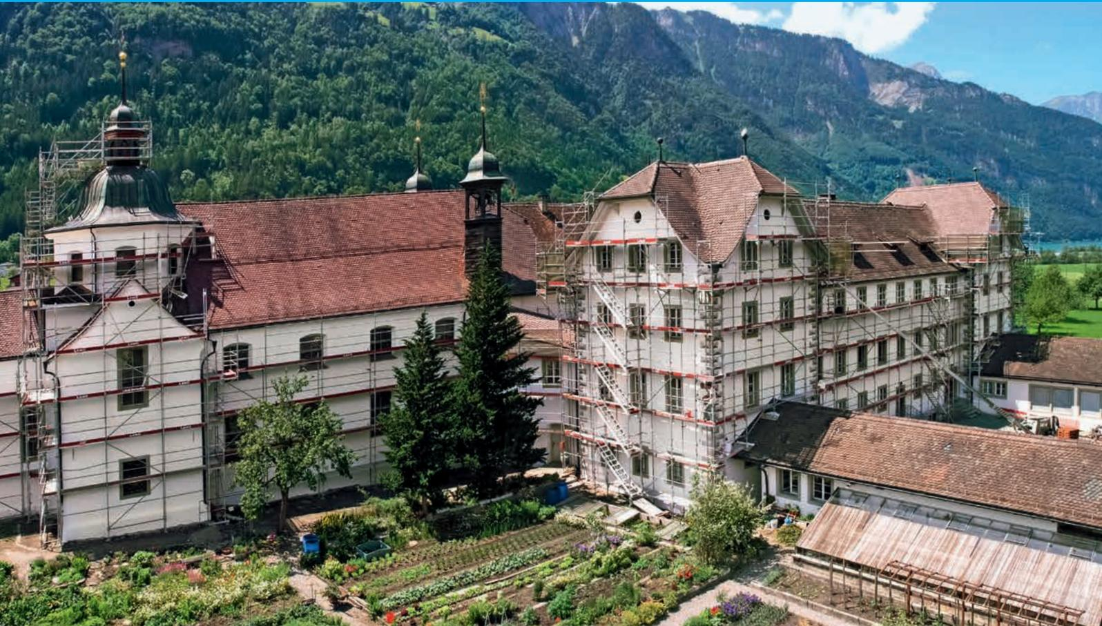
六つの基本要素と僅かな手作業だけで、Layherの代表作はまさに「電光石火」の速さであらゆる作業に安全な基盤を築き上げます。1965年に導入されて以来、市場で標準的な差込式の枠組み足場となっています。簡単で迅速、堅牢で安定しており、建物正面での使用に理想的です。Layher BlitzGerüstは、足場組立用の多面的な部品提供により組立作業用と同じ様に経済的な使用が可能です。
