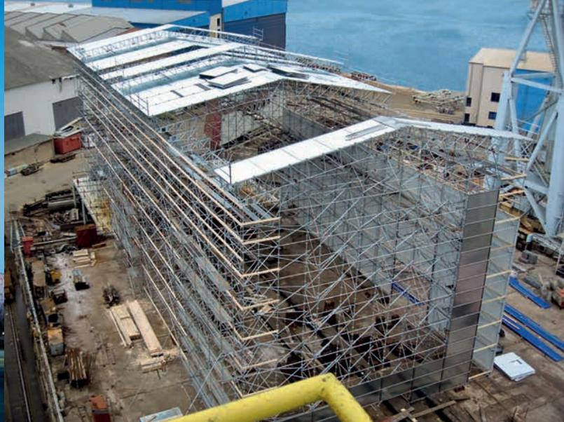
Layher 保護システムは近年の環境保護、騒音保護、耐候保護、および歩行者保護への高い要求を最適に満たし、視覚的な訴求力もあります。その防塵仕様のため、アスベスト除去、外壁塗装、およびサンドブラスト作業の際の最も有力な選択肢となります。優れた騒音絶縁特性のおかげで、このシステムは都心部の工事現場や大規模イベントの会場などで一時的な騒音障壁として使用するにも理想的です。
